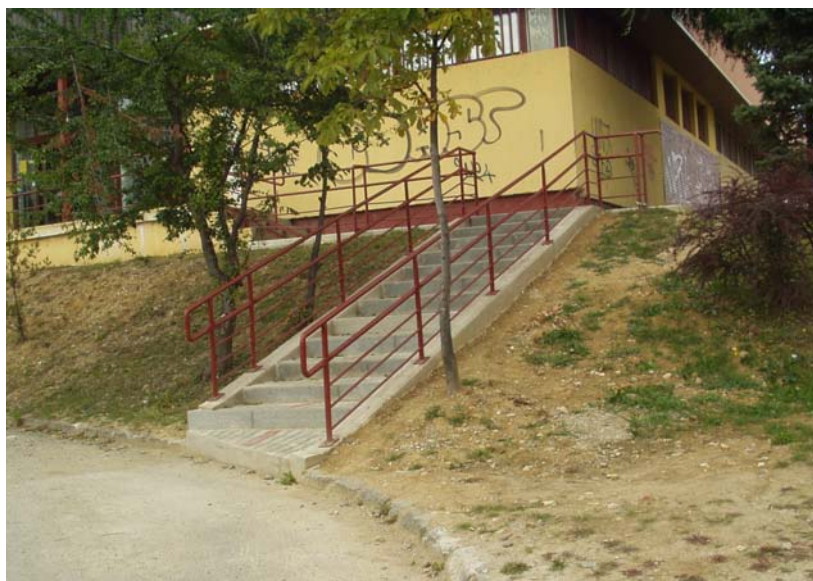
Novovybudované schody k novozriadenej pošte
